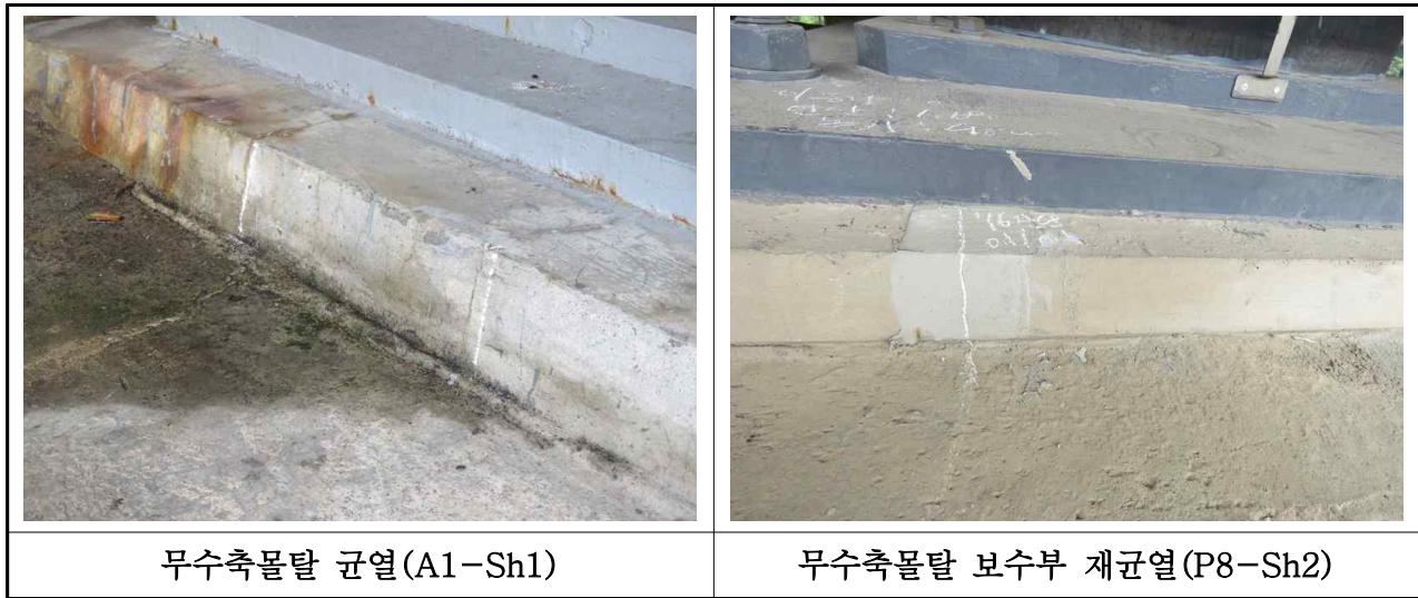
【사진 3.30】 교량받침 손상현황(여주, 계속)
