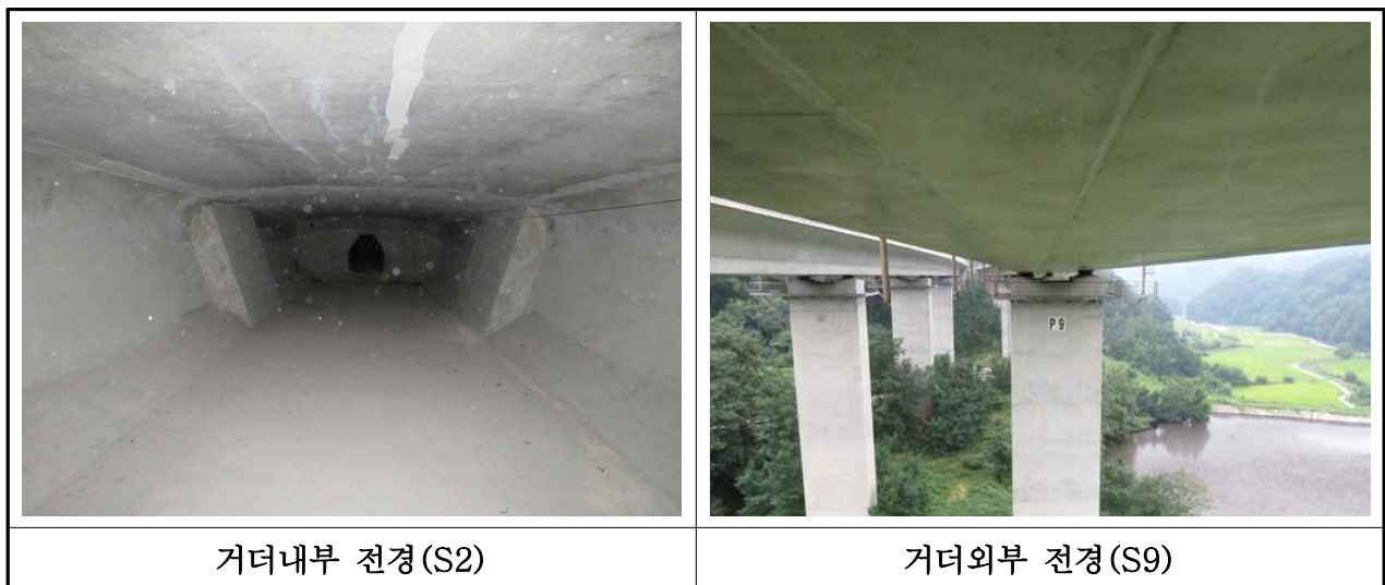
【사진 3.4】 PSC Box 거터 전경(내서)
