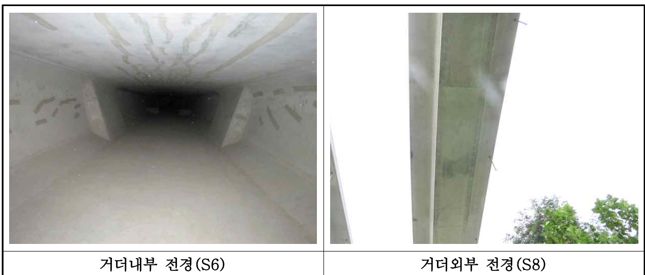
【사진 3.23】 PSC Box 거더 전경(여주)
