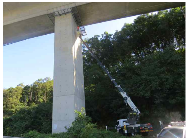
고소점검차를 이용한 조사
