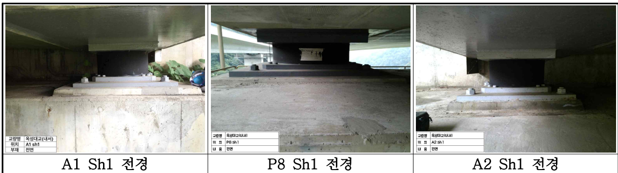
【사진 3.10】 교량받침 전경(내서)
