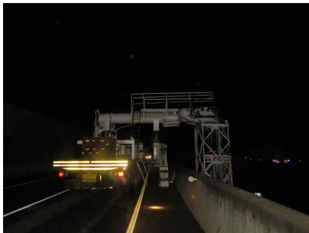
교량점검차를 이용한 조사
