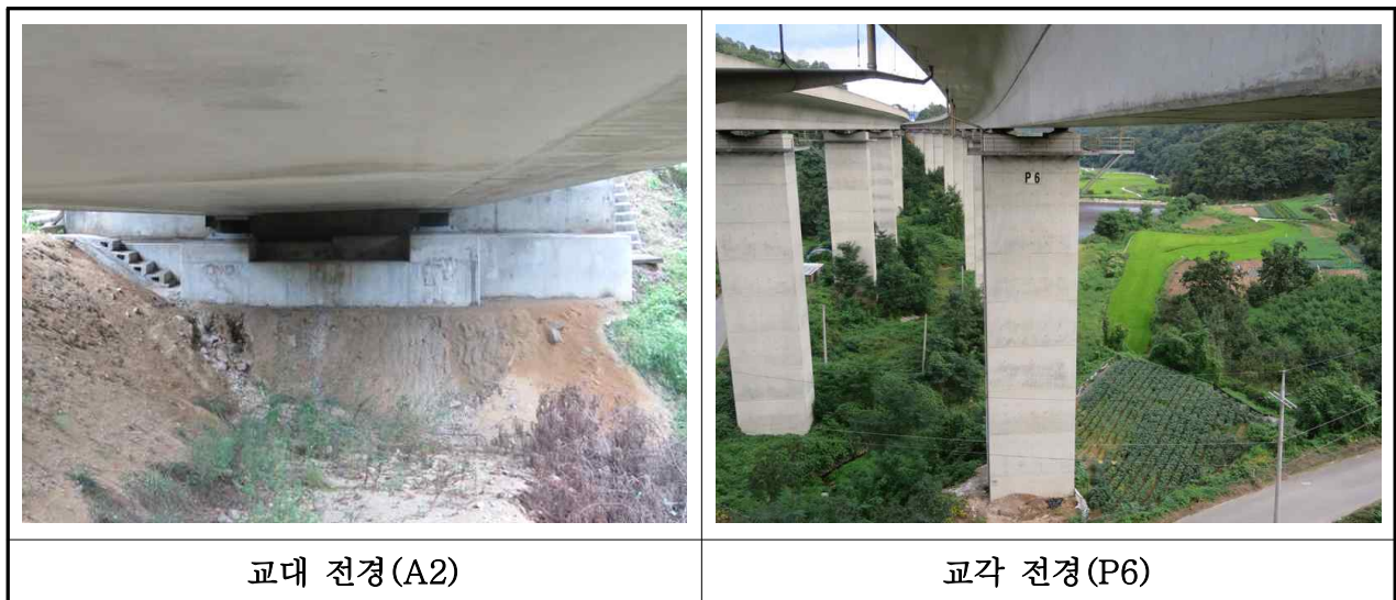
【사진 3.8】 하부 전경 (내서)
