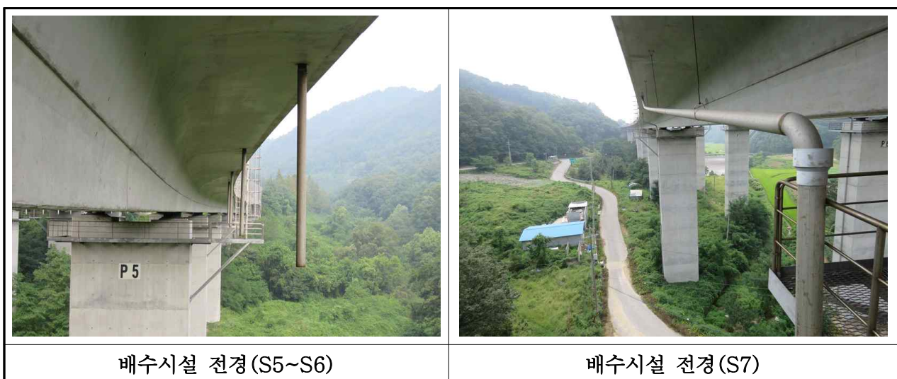
【사진 3.36】 배수구 및 배수관 전경(여주)
