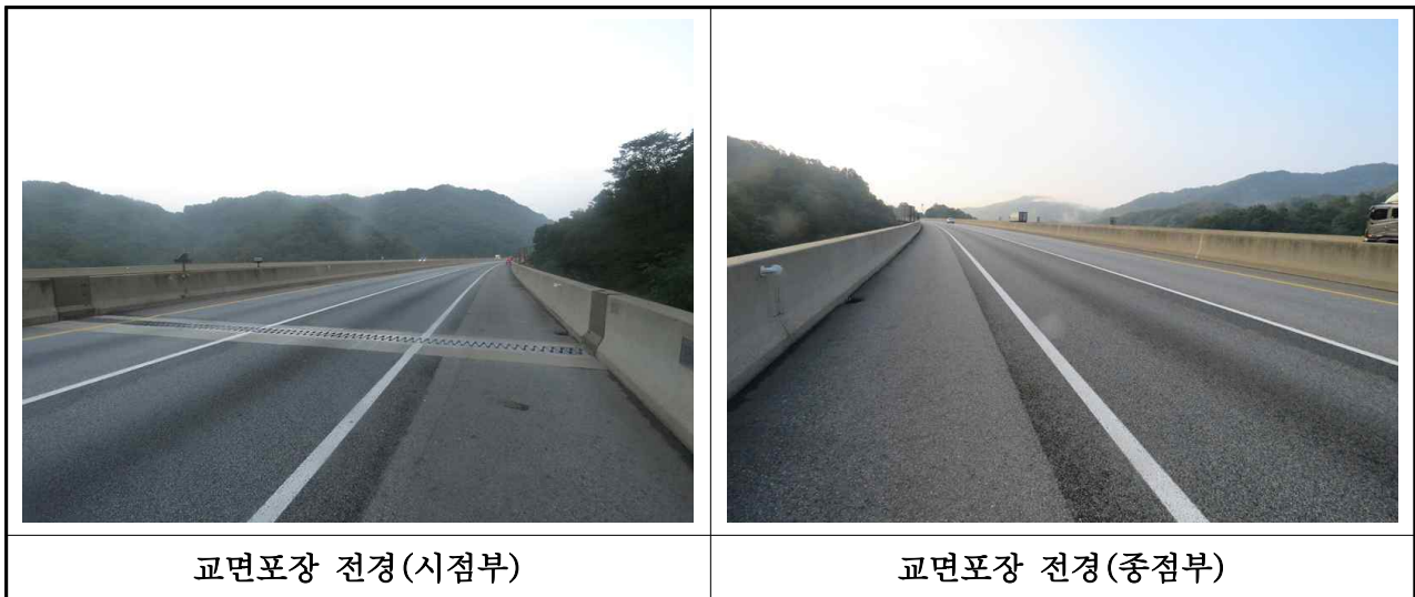
【사진 3.34】 교면포장 전경(여주)
