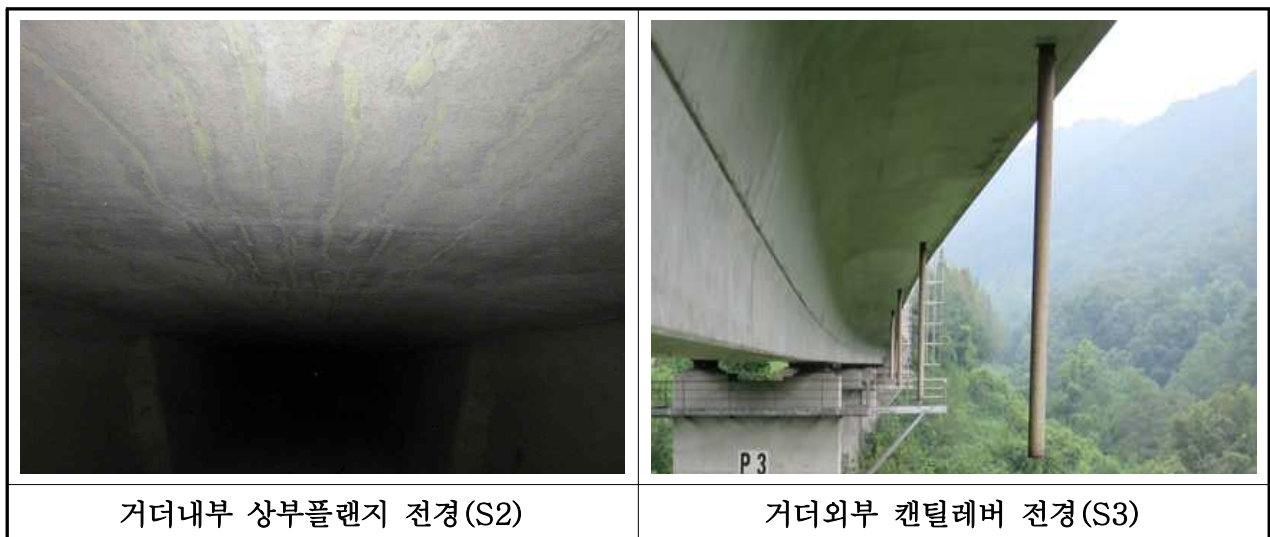
【사진 3.21】 바닥판 전경(여주)
