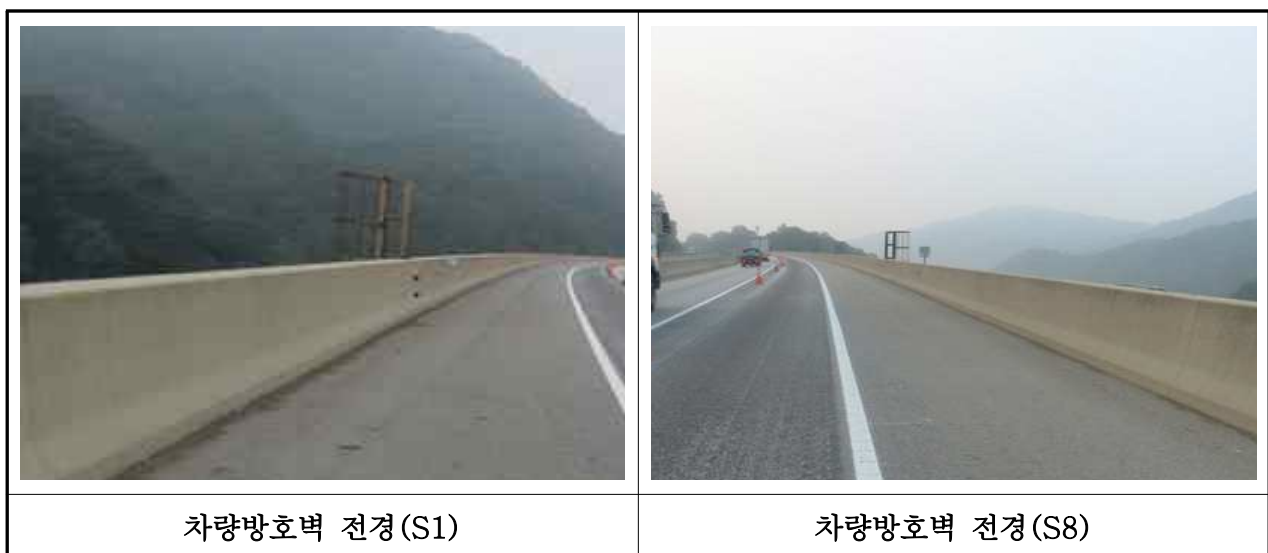
【사진 3.19】 방호벽 전경(내서)
