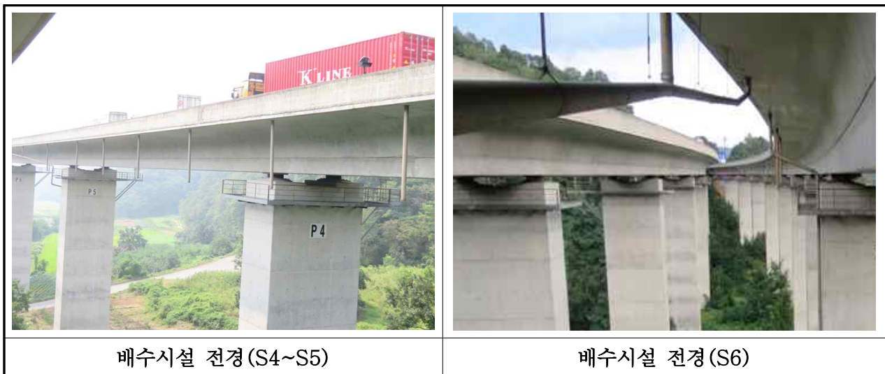
【사진 3.17】 배수구 및 배수관 전경(내서)
