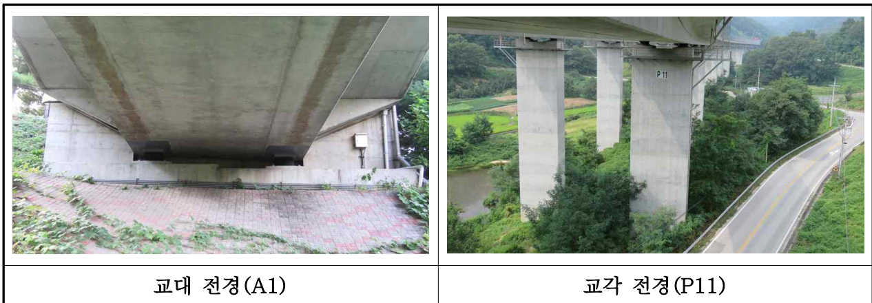
【사진 3.27】 하부 전경 (여주)
