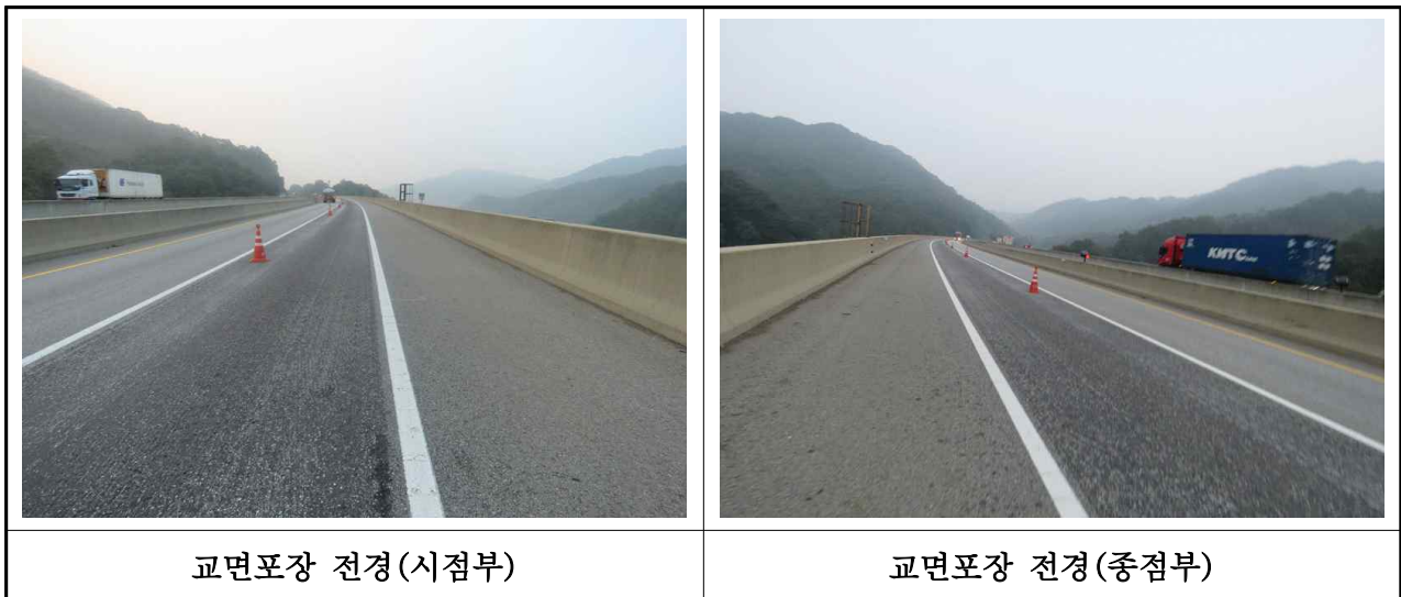
【사진 3.15】 교면포장 전경(내서)
